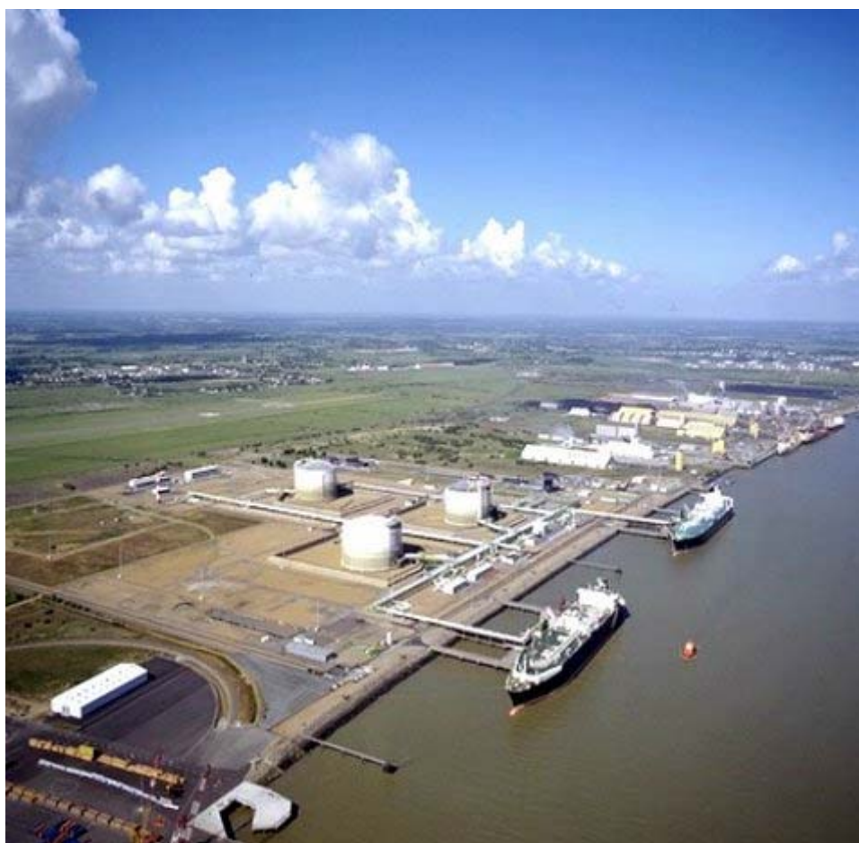
Vue aérienne du terminal de Montoir de Bretagne
